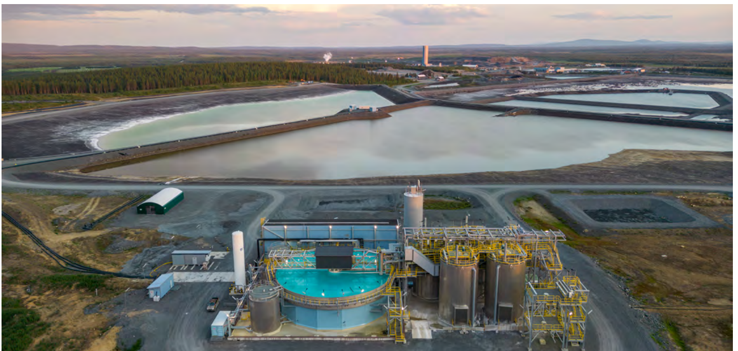
Usine de traitement des eaux à Kittilä (Laponie, Finlande).
