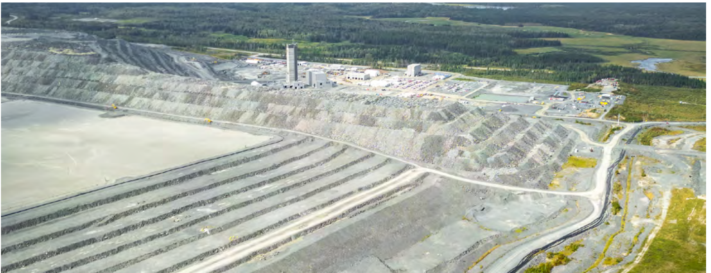
Installation de stockage de résidus, Canadian Malartic, (Québec, Canada)
